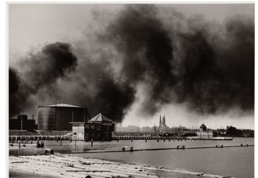
Mei 1940, Brandende olietanks op het terrein van de BPM. Op de voorgrond Haven van Het Y
